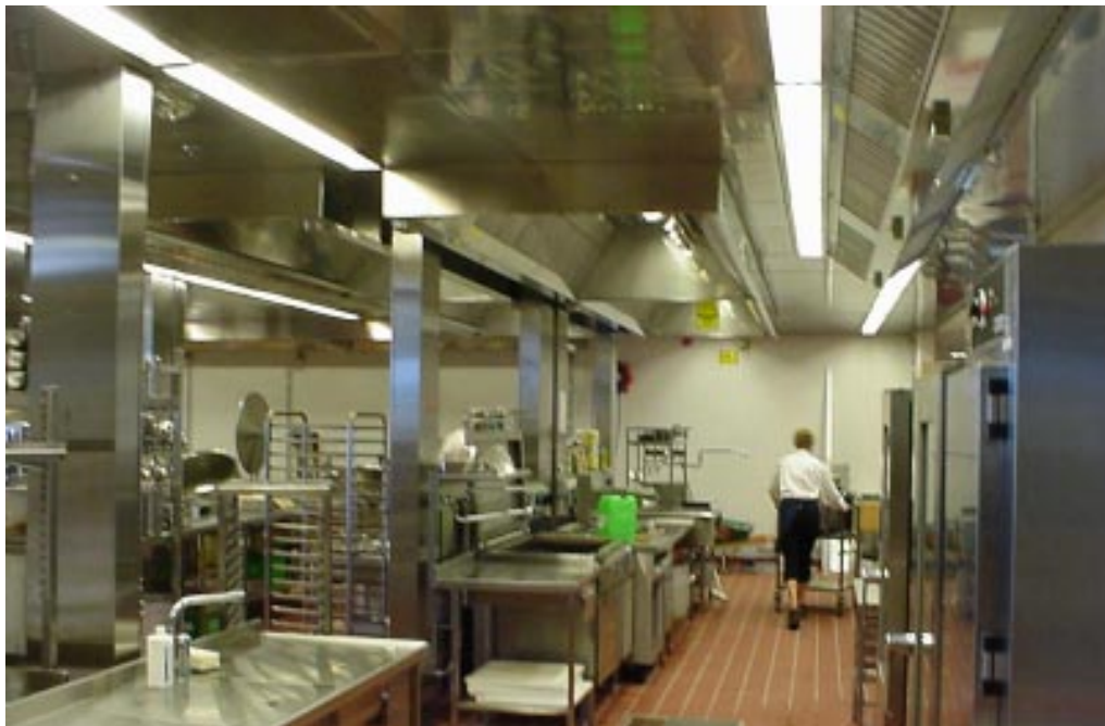
Malmömessans kök, ett ventilationstak på nästan 300 kvadratmeter, helt i rostfritt
